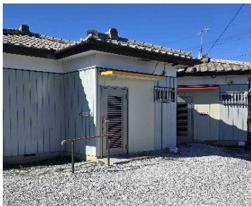
居住棟：スロープがあり、車いすの方でも入りやすいです。
